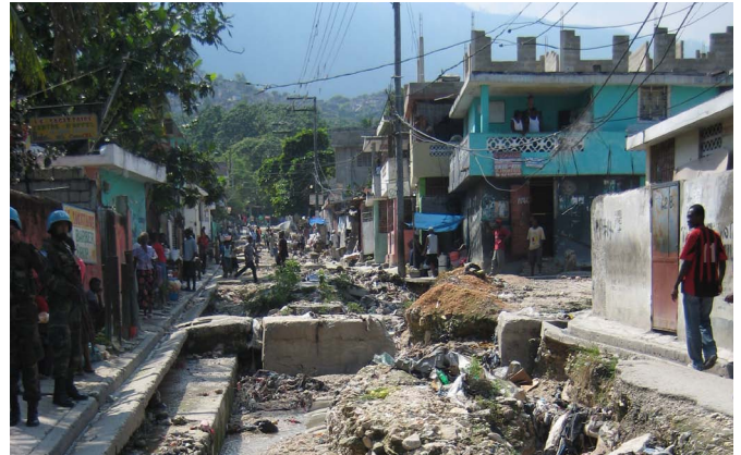
Conduite de drainage en cours d'installation à Cité Soleil
