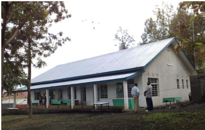
Bâtiment de l'Unité de Gestion des Risques à Goma, RDC.
