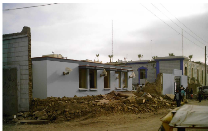
Renouvellement de l'infrastructure du quartier
