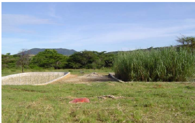
Système de gestion des eaux usées des lagunes à Mombasa, Kenya
