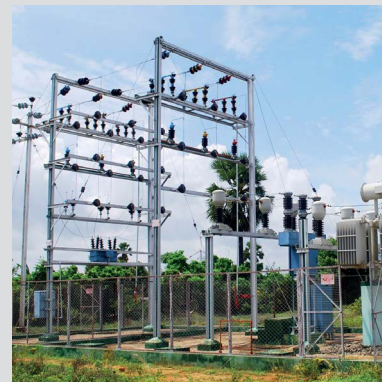
Proyecto para tratar emisiones de carbono en la India.
